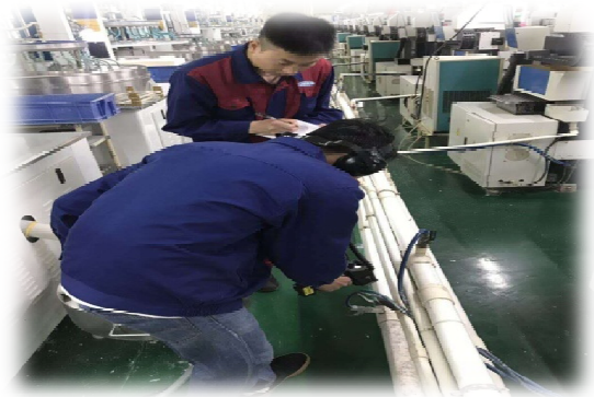
压缩空气漏气检查
